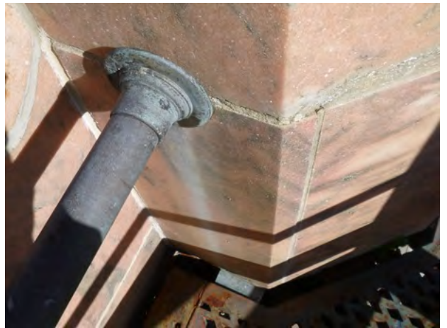
664-197 Stone_Displacement Horizontal 2024-2.jpg
