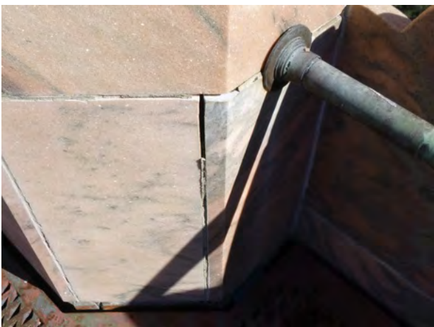
847-198 Stone_Displacement Horizontal 2024-1.jpg
