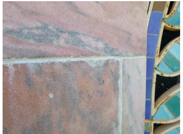
34-172 Stone_Repair Patch Sound 2024-2.jpg
