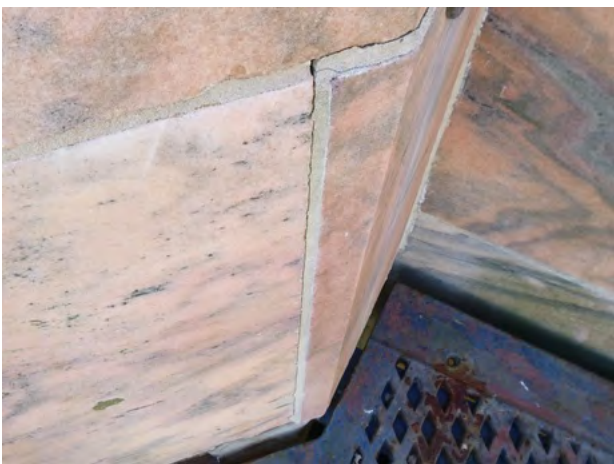
633-196 Stone_Displacement Horizontal 2024-3.jpg
