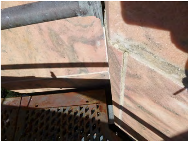
664-197 Stone_Displacement Horizontal 2024-1.jpg
