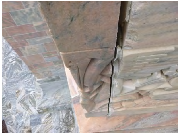
134-30 Stone_Displacement Horizontal 2024-2.jpg
