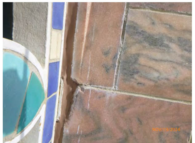
322-170 Stone_Repair Patch Sound 2024-2.jpg
