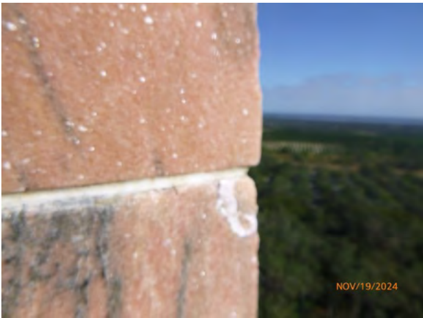
342-181 Stone_Repair Patch Sound 2024-1.jpg
