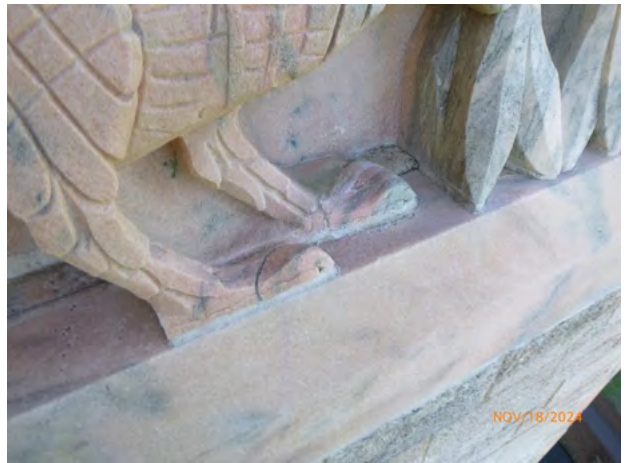
361-138 Stone_Crack Single unit 2024-1.jpg
