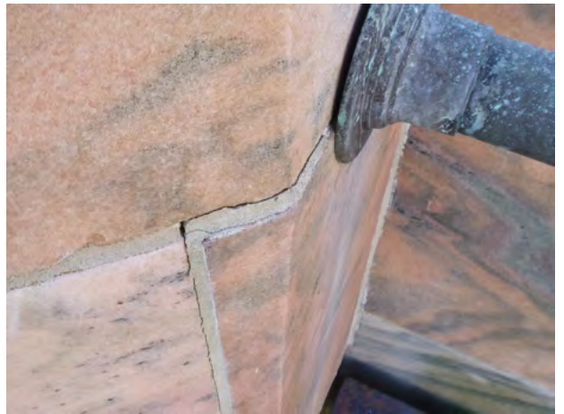
633-196 Stone_Displacement Horizontal 2024-2.jpg
