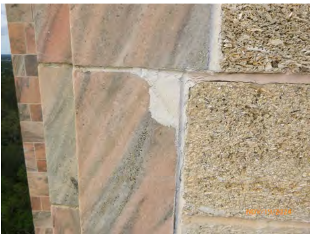
235-101 Stone_Repair Patch Sound 2024-1.jpg
