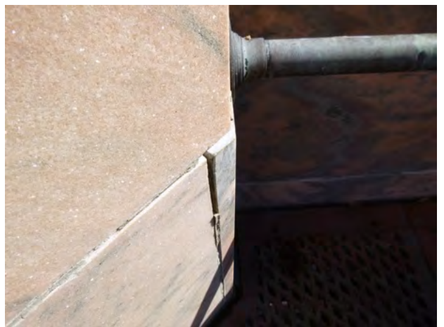
847-198 Stone_Displacement Horizontal 2024-2.jpg
