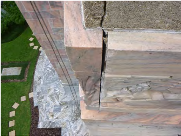
134-30 Stone_Displacement Horizontal 2024-1.jpg
