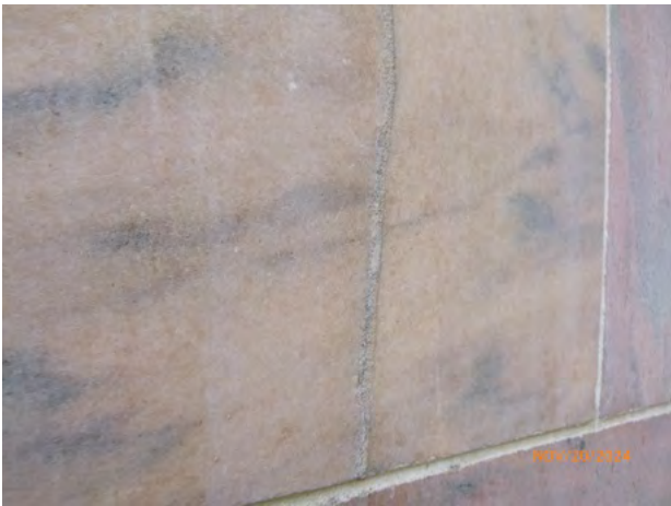
130-74 Stone_Crack Repair sound 2024-2.jpg
