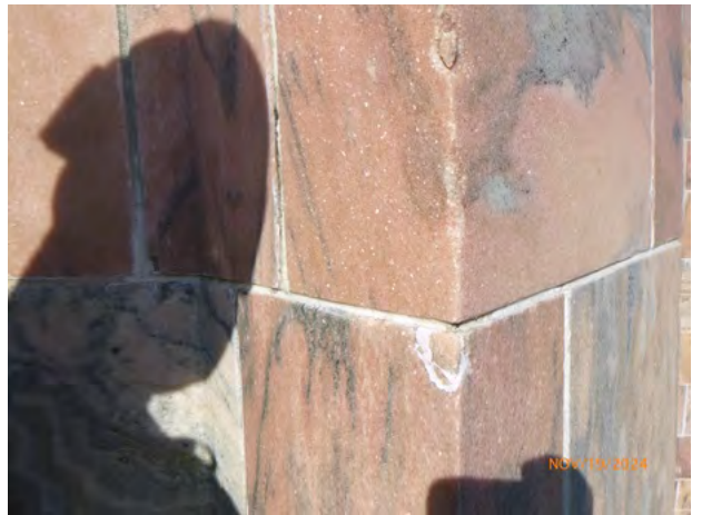
342-181 Stone_Repair Patch Sound 2024-2.jpg
