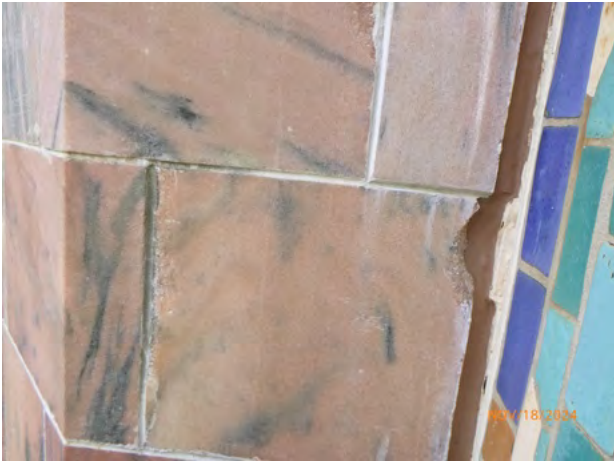
346-172 Stone_Repair Patch Sound 2024-2.jpg
